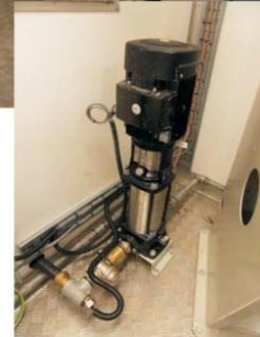
Blandningsrum med blandare, pump, vattenpump. Styrskåp touchpanel och inbyggt printerskåp. Blandare utrustad med vattenautomatik och flödesmätare. Frekvensstyrd pump med 200 liters kar med omrörare och nivågivare för automatisk drift.
