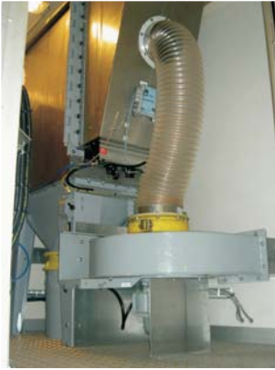
Maskinhuset med Generator, Slangvinda, Dammfilter och Kompressor
