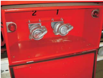
Anslutning för påfyllning från bulk med lampindikering för full silo
