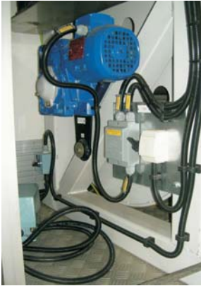
Maskinhuset med Generator, Slangvinda, Dammfilter och Kompressor
